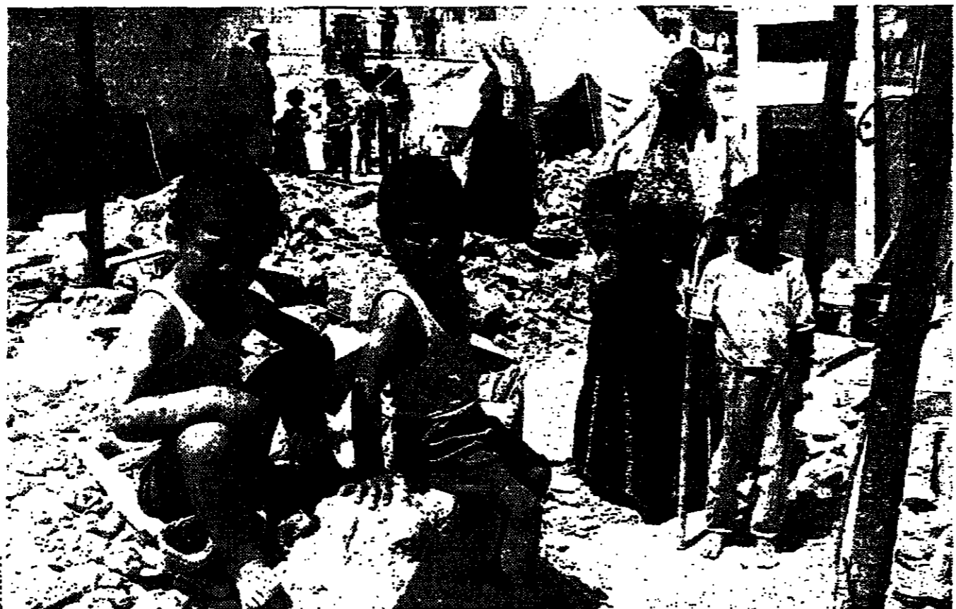
MAISON DÉTRUITE DANS LE CAMP DE RAFAH (GAZA) Toujours l'intifada, malgré les mesures punitive
